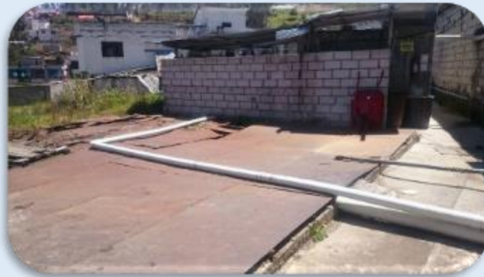
Tanque reservorio N°2
