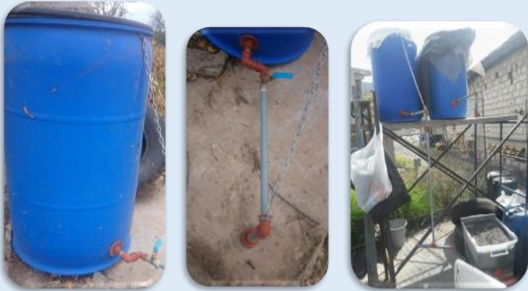
Tanque de almacenamiento del agua residual
