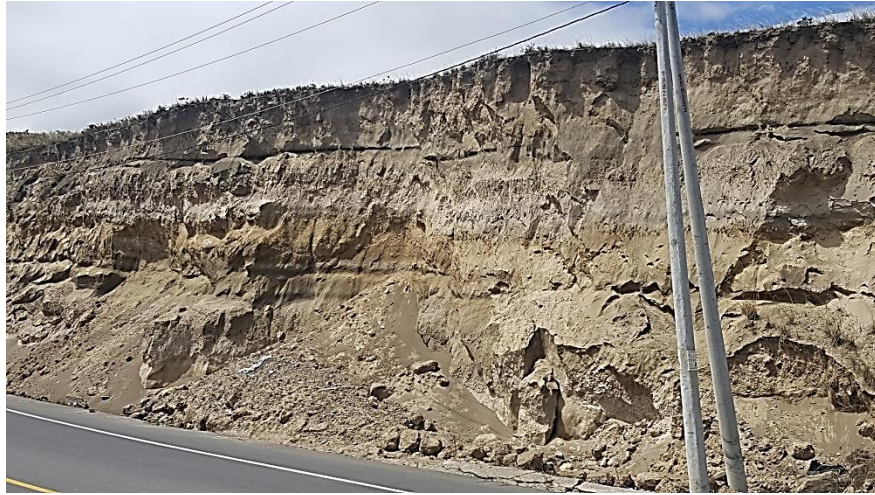
Fotografía N° 2. Perfil del talud Abscisa 3+500
