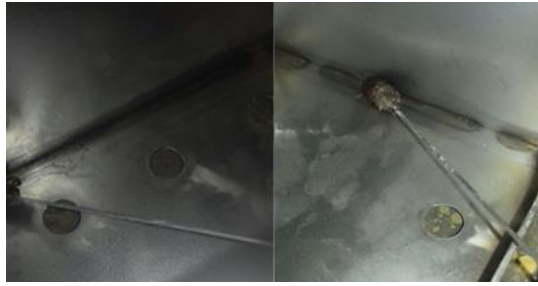
Figura 71.- Aplicación y limpieza con ácido para eliminación de impurezas.
