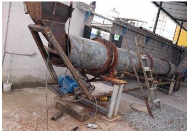
Figura 3. 49. Instalación de la cámara de secado.
