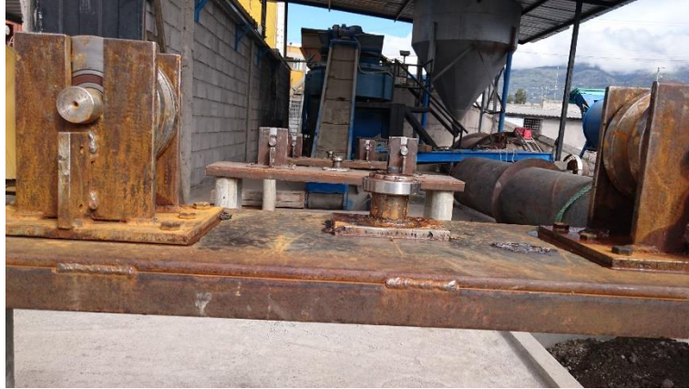
Figura 3. 45. Colocación de los rodillos de soporte.
