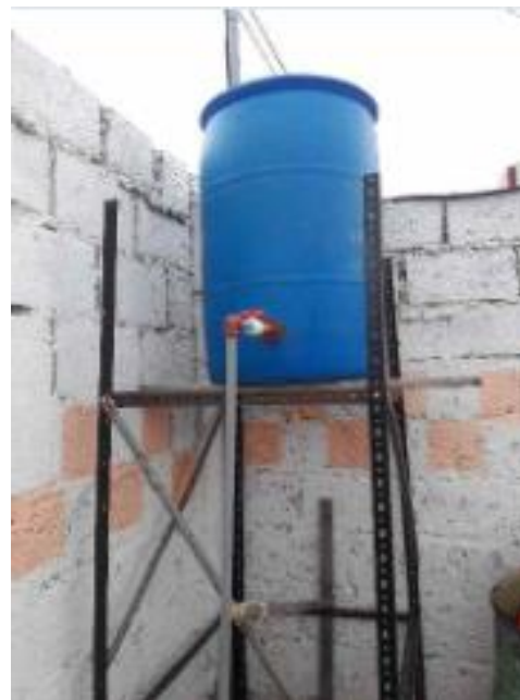
Válvula para la calibración del caudal
