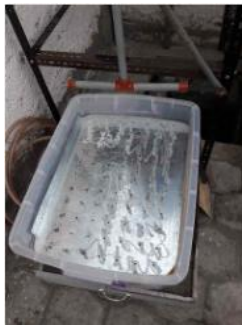
Plancha de tol para distribuir el agua residual.
