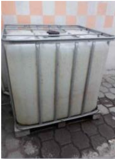
Tanque reservorio de 1000 ltrs de la lavadora
