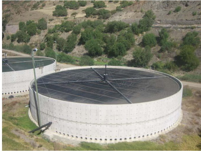
Foto 3: Vista del filtro biológico
