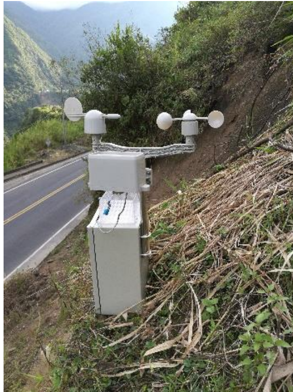
Figura N°. 63: Instalación del prototipo en la zona afectada
