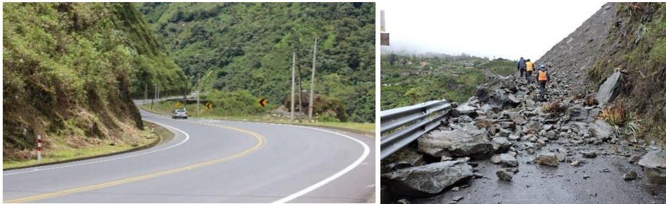
Figura N°. 25: Inclinación y material de laderas
