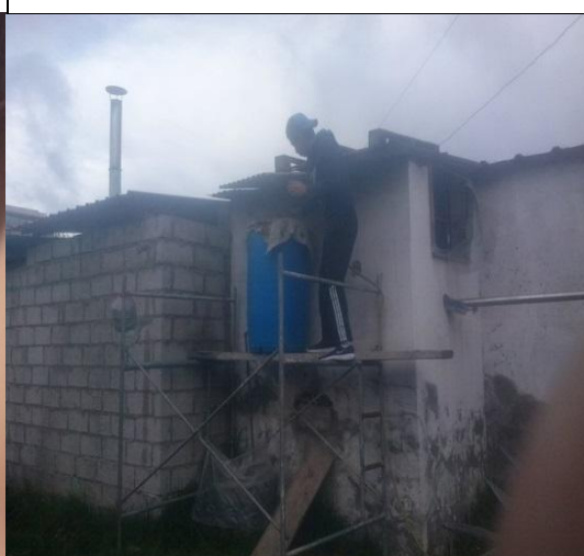
Estructura del filtro.
