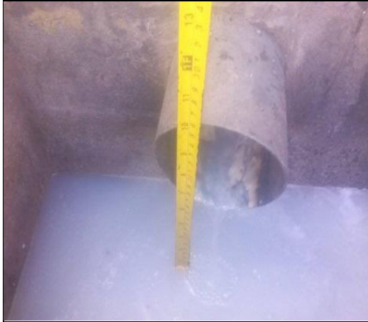
Medición del tirante Hidráulico.
