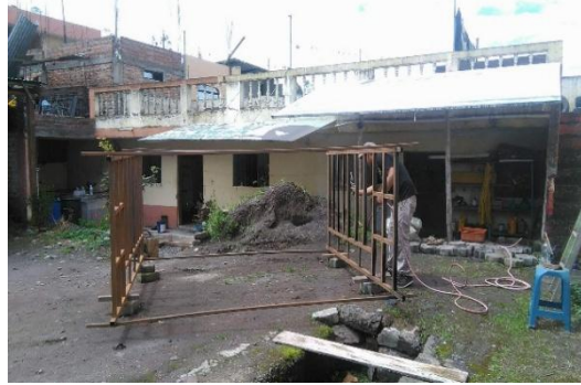
FIGURA 16. Construcción de la Estructura
