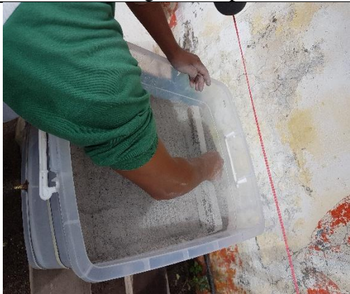
FIGURA 32. Tercera Capa de Material
