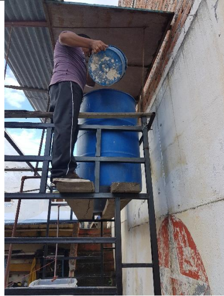
FIGURA 41. Llenado del Tanque Contenedor
