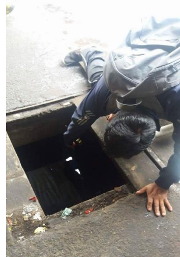
FIGURA 15. Medición del Altura de Agua de la Cisterna
