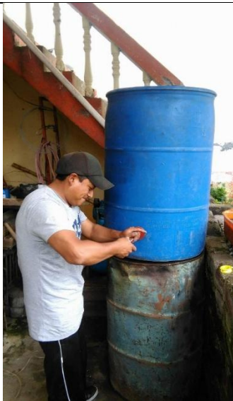
FIGURA 18. Colocación del Acople
