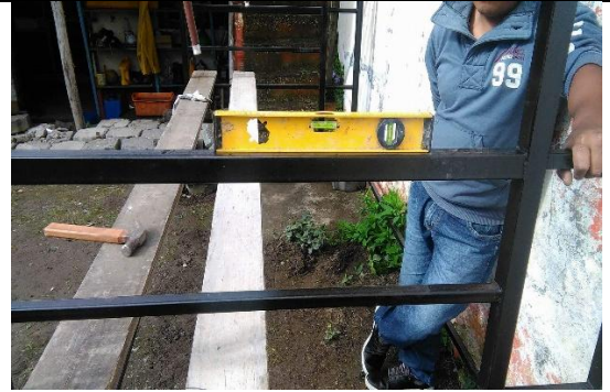
FIGURA 17. Nivelación de la Estructura
