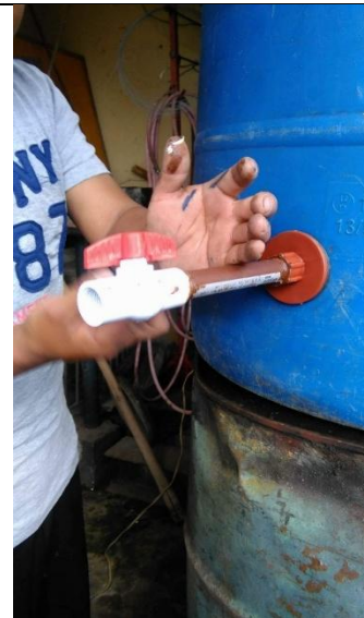
FIGURA 19. Colocación de Válvula
