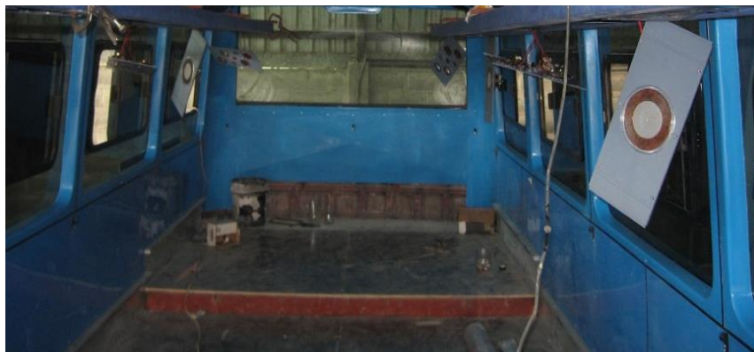
Figura 3. 7 Construcción del piso. Fuente: [28].
