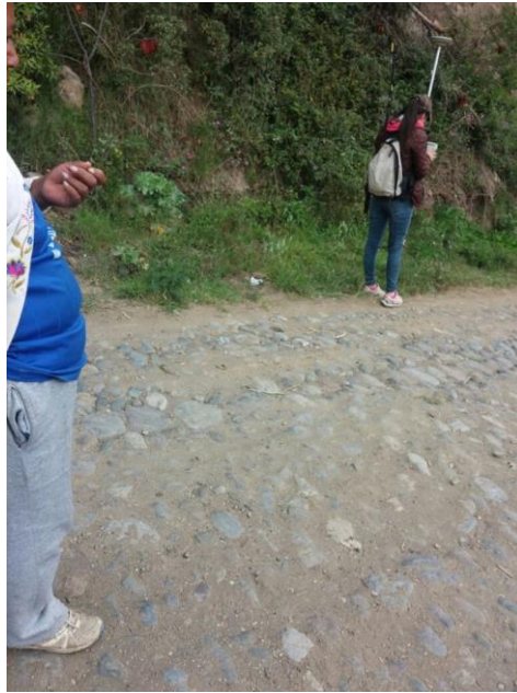
Foto N°1.- Levantamiento Topográfico para el alcantarillado
