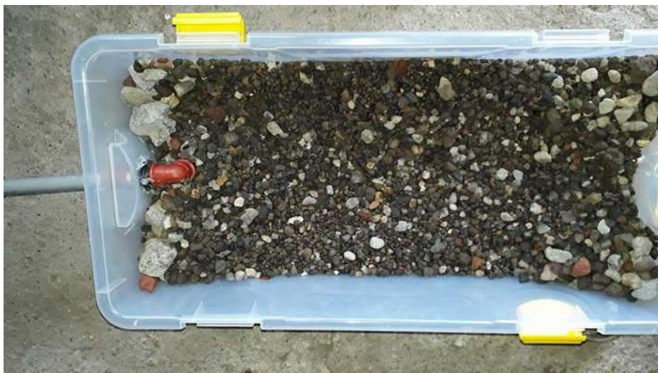
Foto N°5.- Colocación de la grava en el humedal
