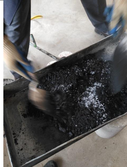
Incorporación de la mezcla modificada.
