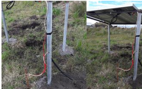
Figura 60: Puesta a tierra del sistema
