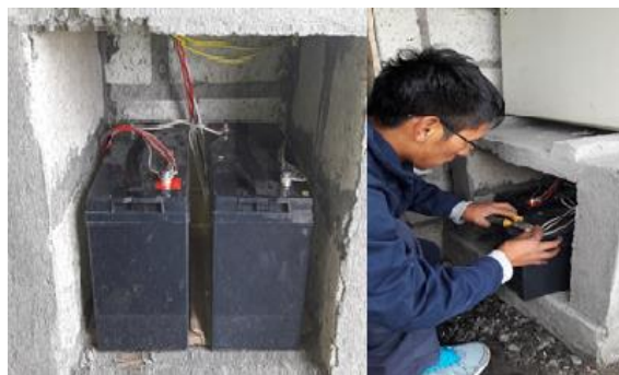
Figura 59: Instalación del banco de baterías
