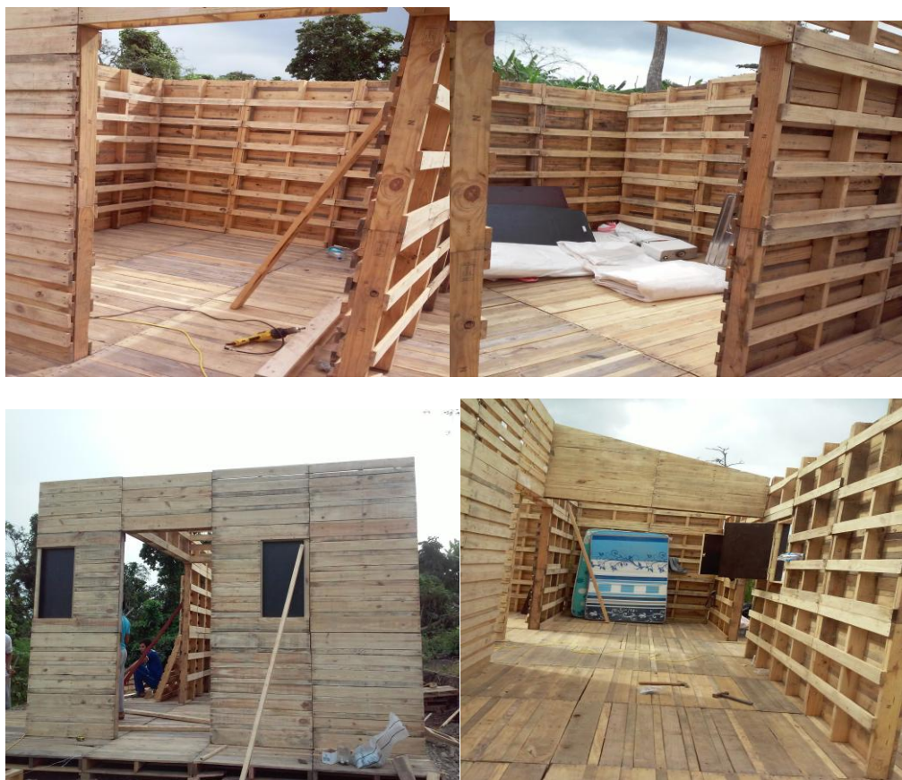
Imagen N°8: Proceso de construcción de la vivienda Fuente: Empresa Plasticaucho S.A.
