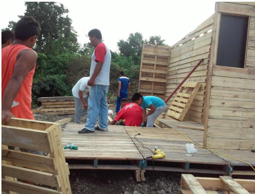
Imagen N°7: Proceso de montaje de la casa en el terreno del beneficiario Fuente: Empresa Plasticaucho S.A.
