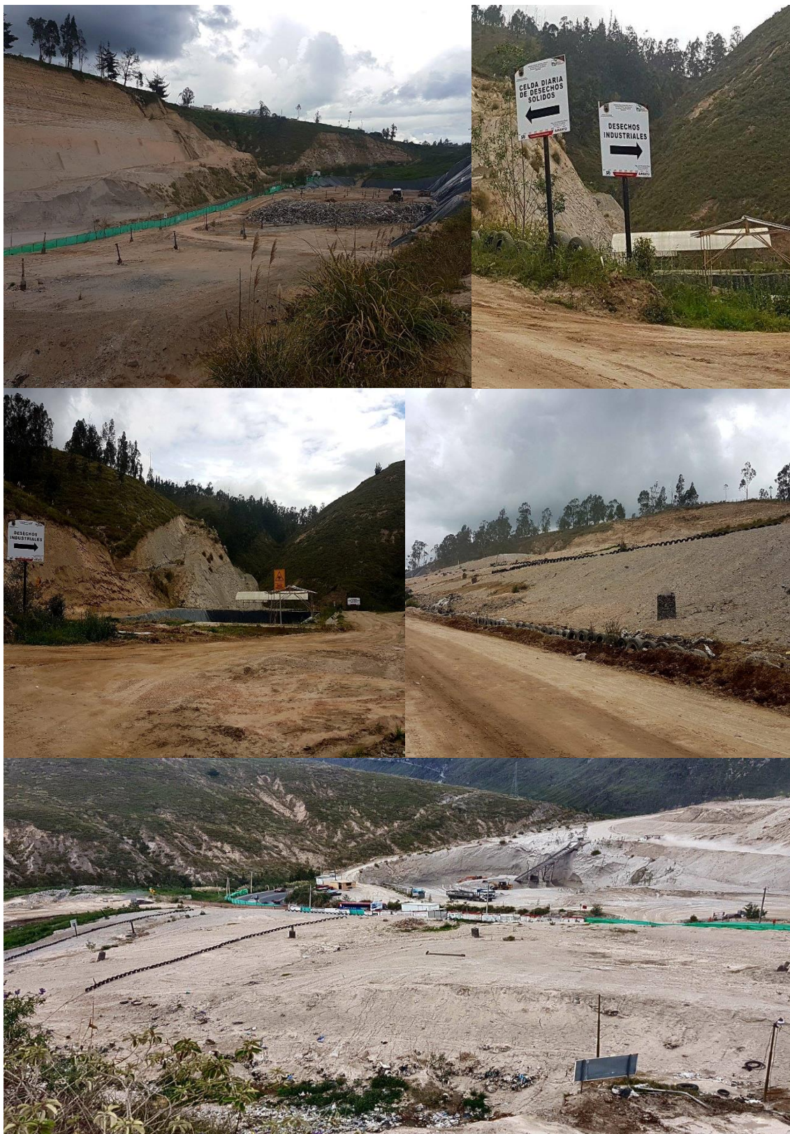
Figura 8. Interior del Relleno Sanitario
