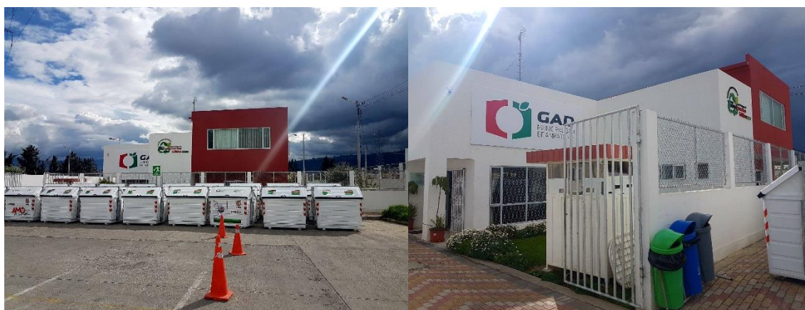
Figura 6. Edificio Administrativo EPM-GIDSA
