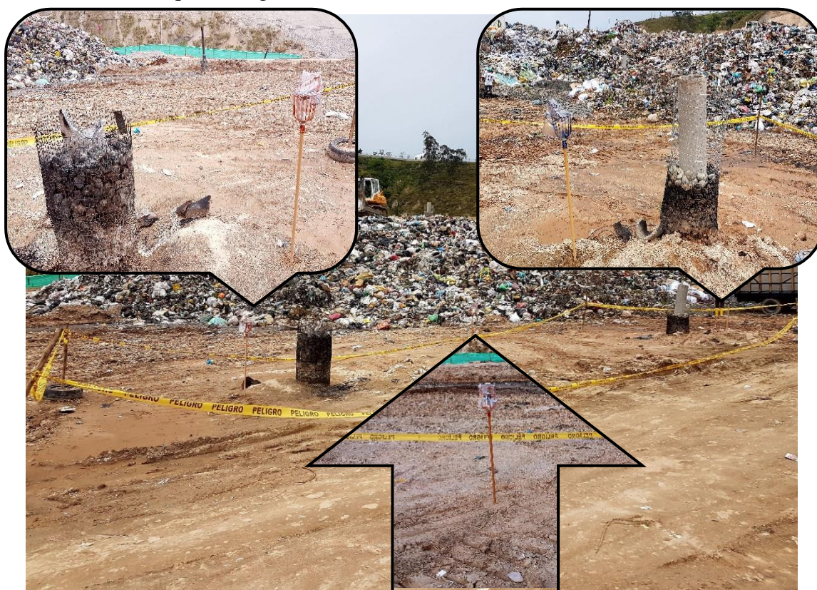
Figura 33. Instalación Dispositivos en el Relleno Sanitario Elaborado por: Investigador
