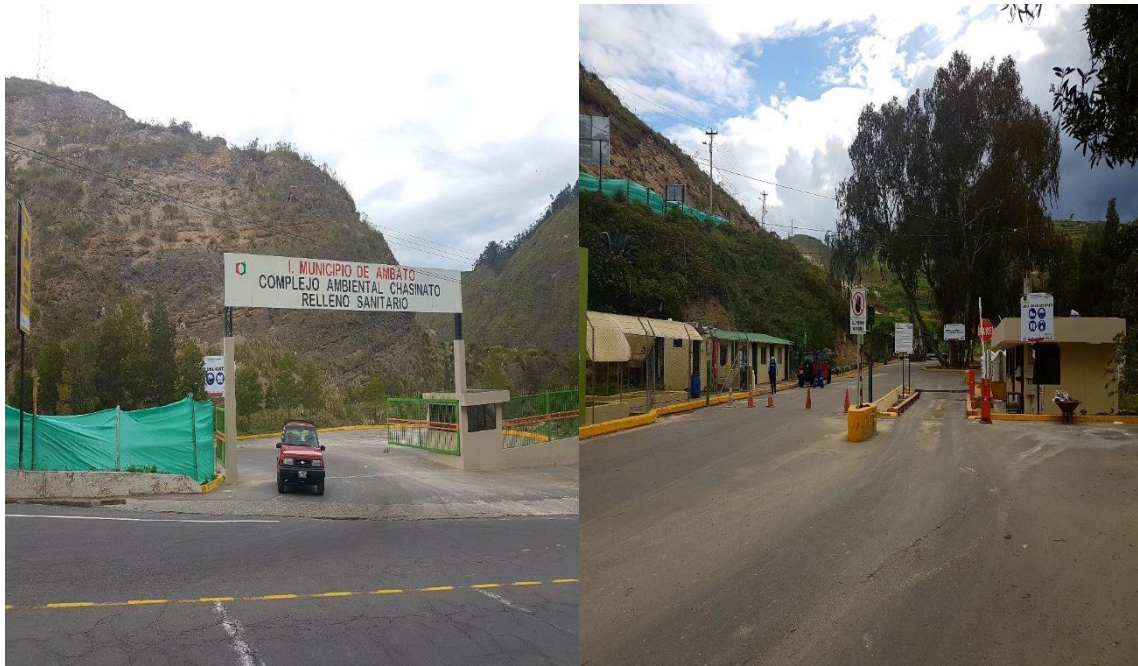
Figura 7. Entrada y Báscula - Relleno Sanitario
