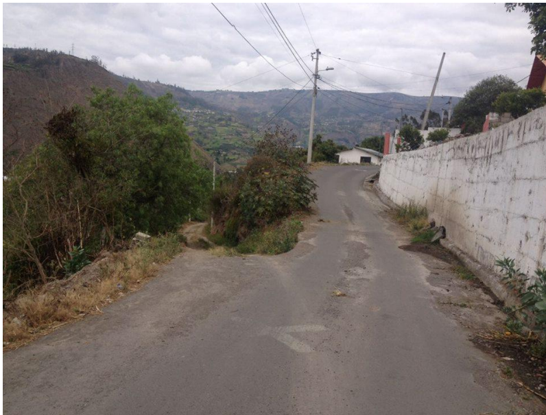
Fotografía N° 1 Vía Asfaltada Calle A
