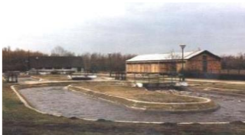
FIGURA 5 ZANJA DE OXIDACIÓN.
