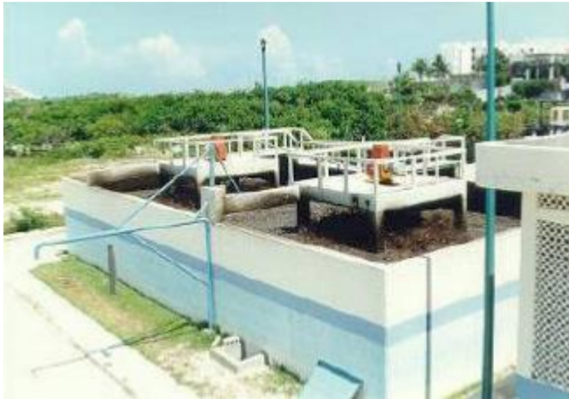
FIGURA 4 PLANTA DE LODOS ACTIVADOS CONVENCIONAL.
