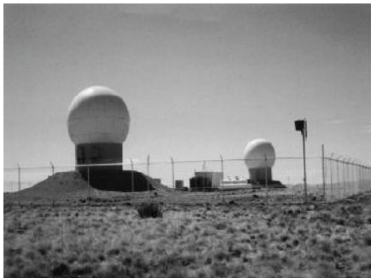
Figura 6.2: Radio-domos de un GES
