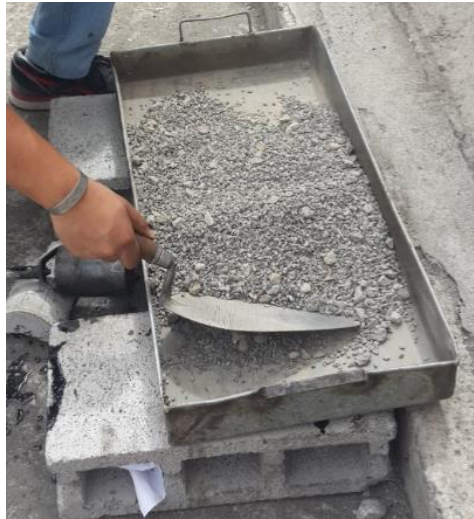
Figura 20: Calentamiento de los agregados a 180 °C
