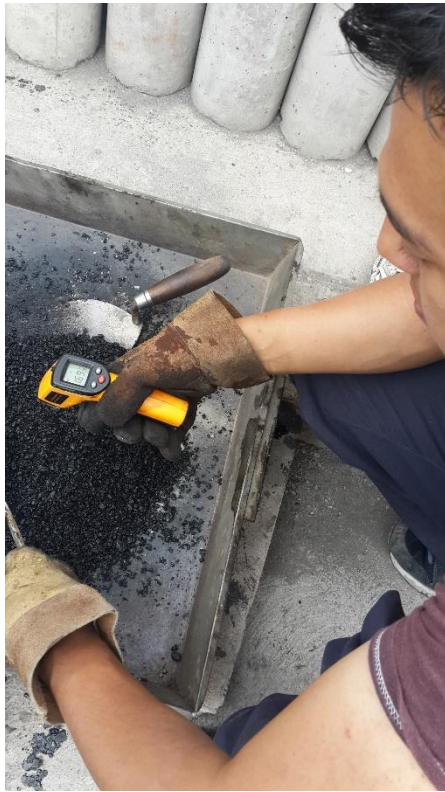
Temperatura de la mezcla asfáltica 180 °C
