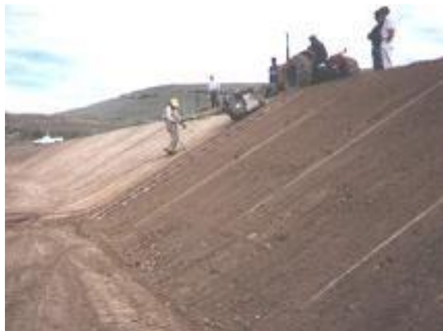
Gráfico N° 48. Preparación del Talud
