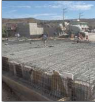
Gráfico 6.- Armado de una losa de hormigón
