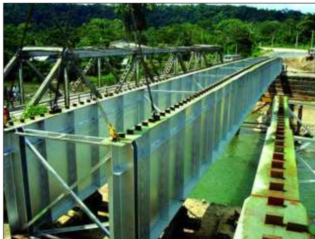
Gráfico 7.- Vigas metálicas del puente sobre el río Misahualli
