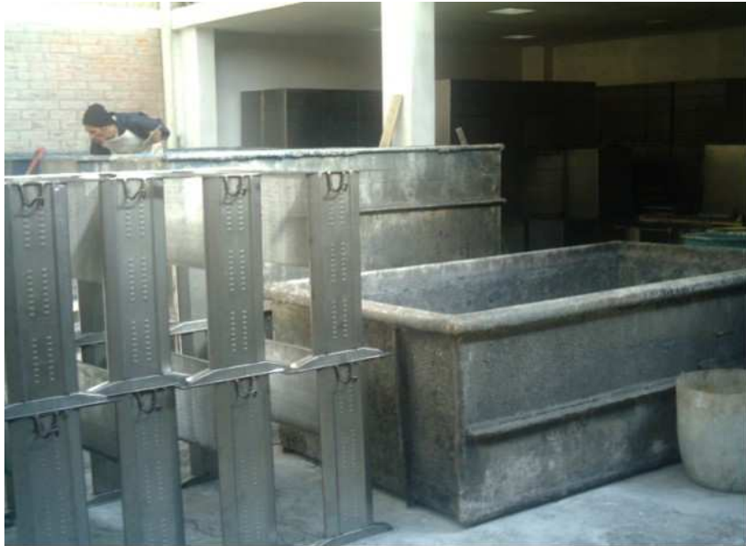
ESTRUCTURAS EN PROCESO
