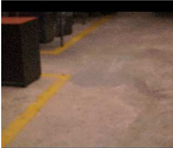
CENTRO DE ACOPIO
