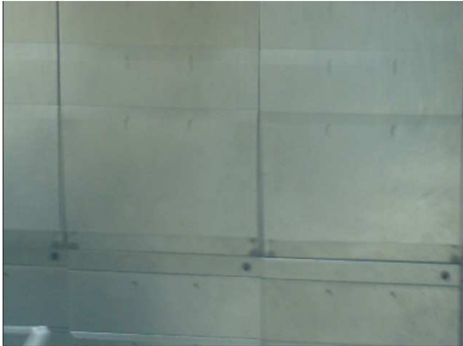
APILAMIENTO DE CAJONERAS
