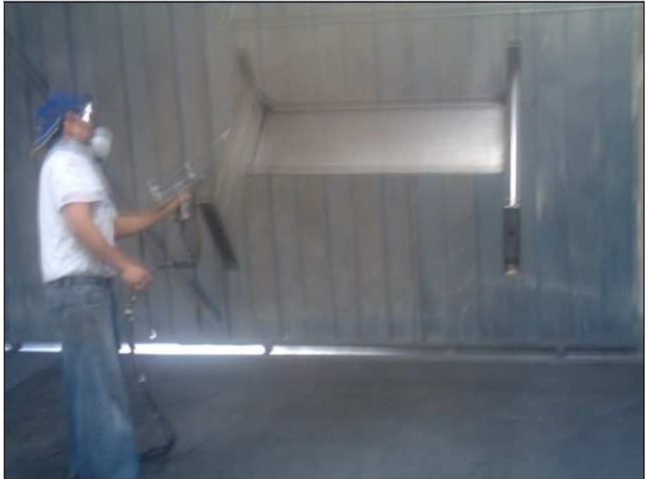
AREA DE PINTURA DE COLORES VARIOS
