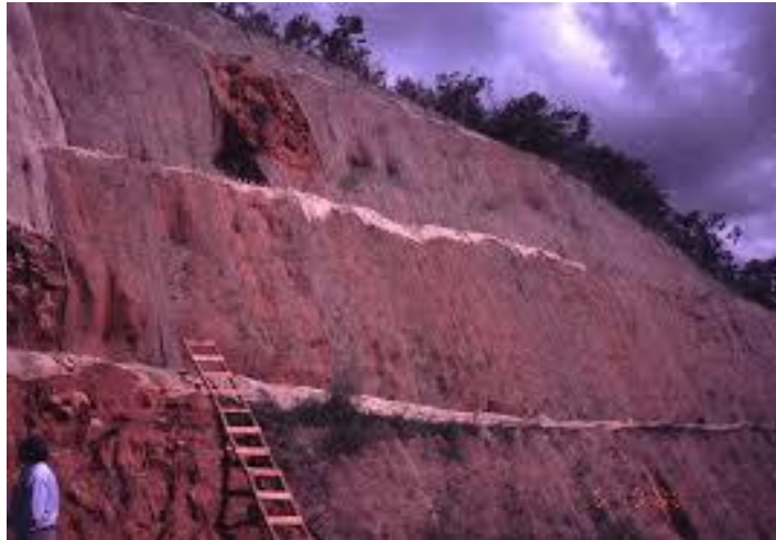
Gráfico N° 54.-Terracería en Taludes
