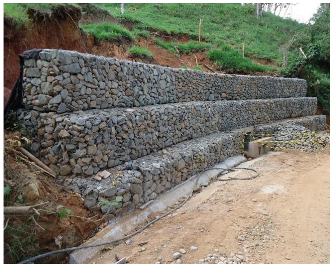
Gráfico N° 52.-Muro de gaviones
