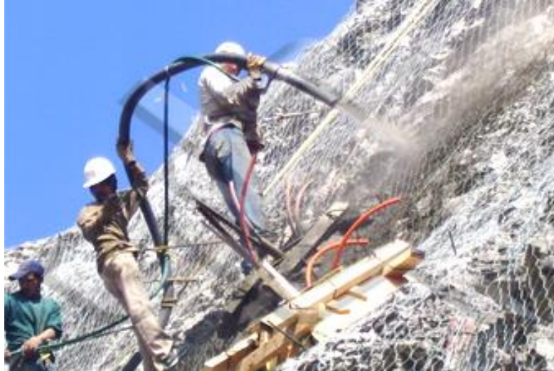
Gráfico N° 51.-Concreto lanzado con malla electrosoldada
