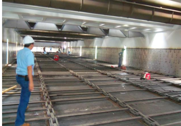
Figura 34: Interior de la cámara de extracción de jugo Fuente: Compañía azucarera Valdez
