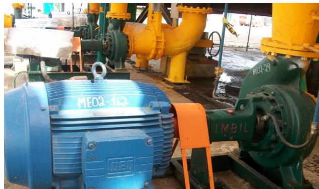
Figura 54: Motor eléctrico, bombas Imbil, extracción de jugo de la cámara del difusor.
