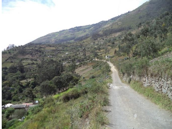
ESTADO ACTUAL DE LA VÍA (EL TROJE)
