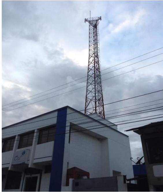
Fig. 4. 20 Medición a 20m de estación base
