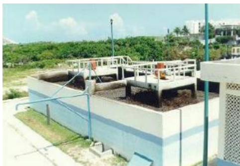
Fig.4. Planta de lodos activados convencional
