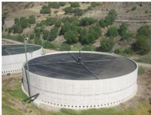
Figura N° 9. Vista general de un filtro percolador
