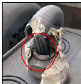
*Figura 4. 3 Cable de alimentación en mal estado.*
