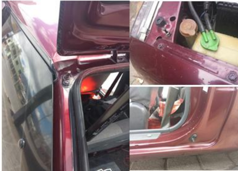
Figura 4.55 Instalación de los Pulsadores en las puertas y compartimientos Fuente: El Investigador
