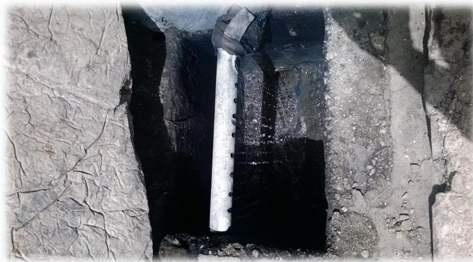
*Fotografía 20.- Evacuación de los efluentes al sistema de alcantarillado*
