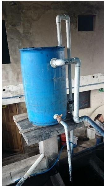
*Fotografía 10.- Tanque de mezcla rápida*
