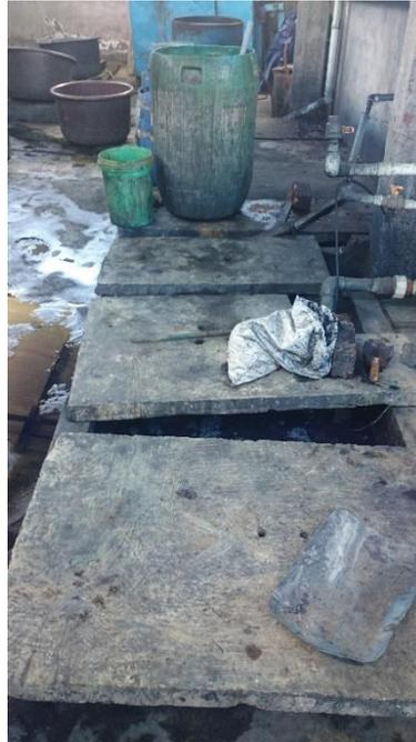
*Fotografía 5.-Trampa de grasa y homogenizador*
