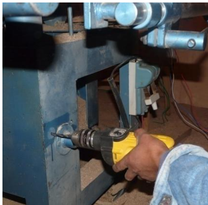
Figura 6.1 Realización de los agujeros de 1/4 de pulgada
