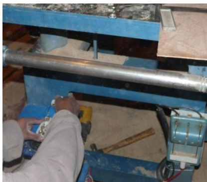
Figura 6.4 Realización de las conexiones
