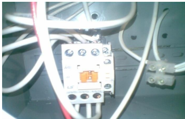
Figura 7.6 Contactor Fuente: (Autor)
