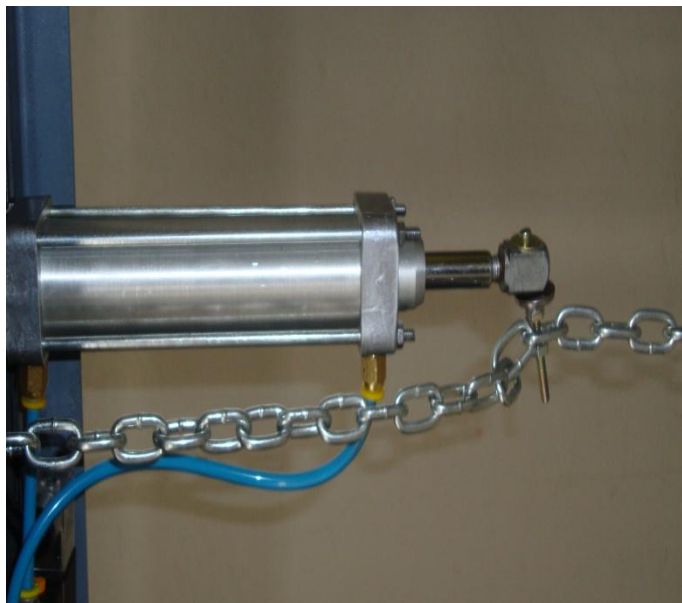
Instalación del pistón neumático
