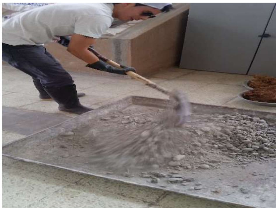
Fotografía N° 6.- Mezcla de materiales
