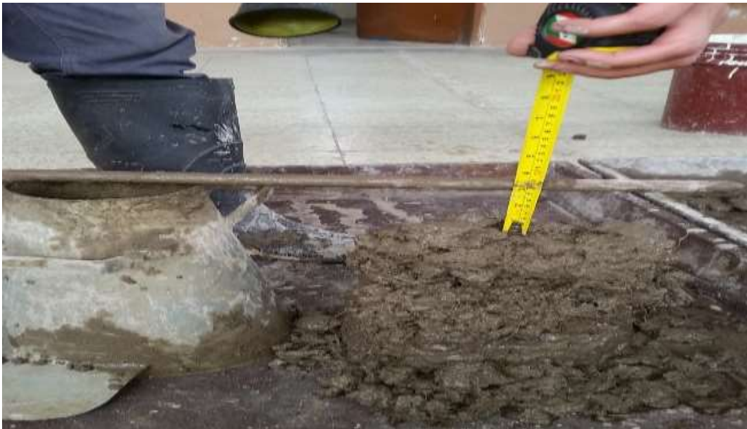
Fotografía N° 11.- Ensayo de consistencia de la muestra
