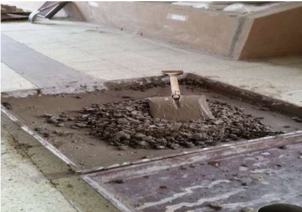
Fotografía N° 9.- Visualización de la mezcla de hormigón
