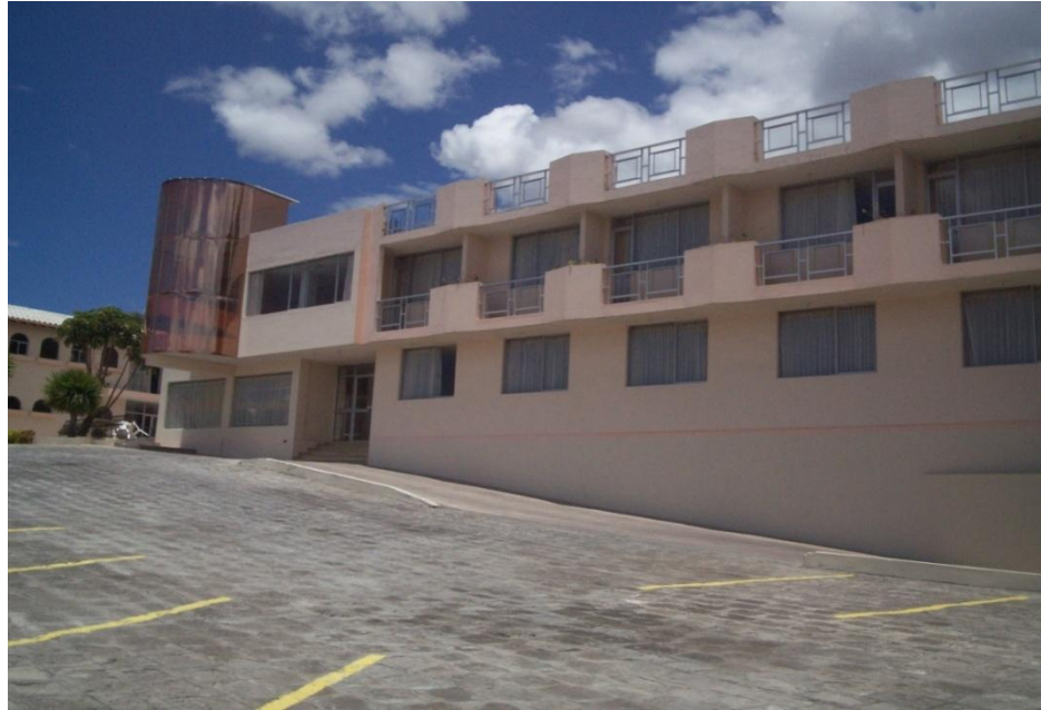
FACHADA DEL HOTEL
