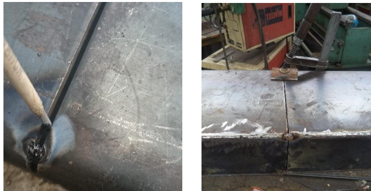
Figura 4. 23 Pre soldeo de columnas
