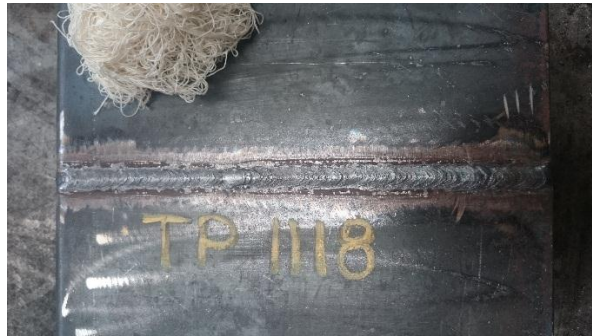
Figura 4. 28 Aplicación del Limpiador (cleaner)
