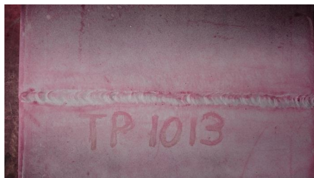
Figura 4. 30 Aplicación del revelador en la soldadura
