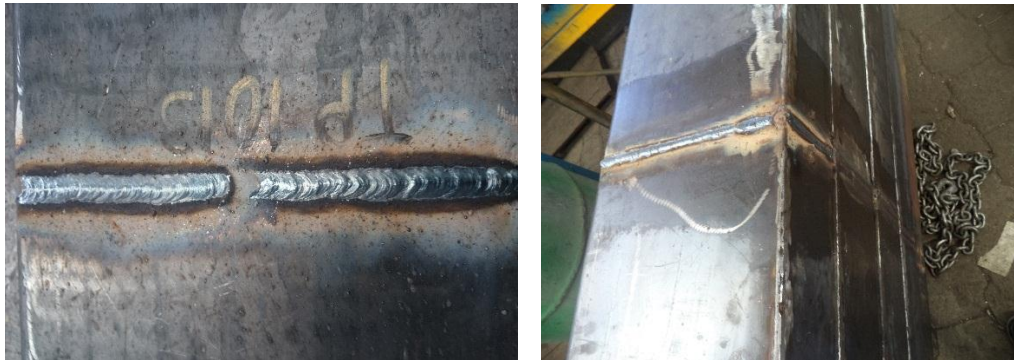
Figura 4. 26 Soldadura de acabado
