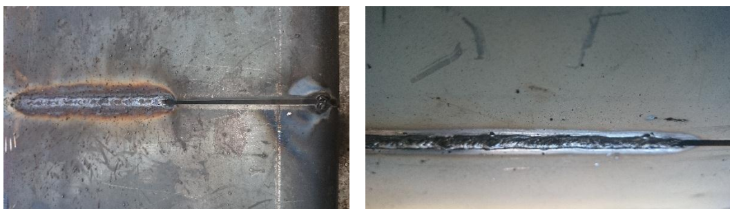
Figura 4. 24 Soldadura de penetración en columnas
