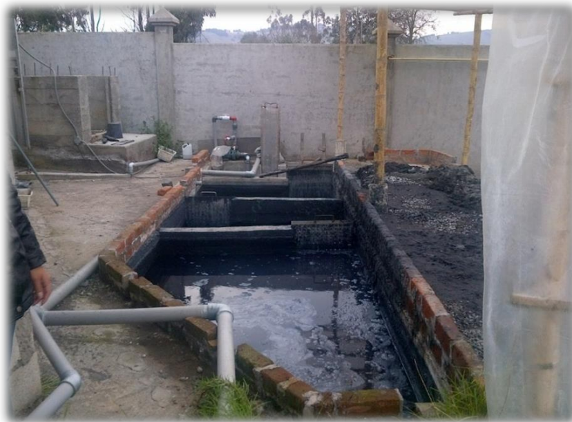
Fotografía 30.-Planta de tratamiento existente
