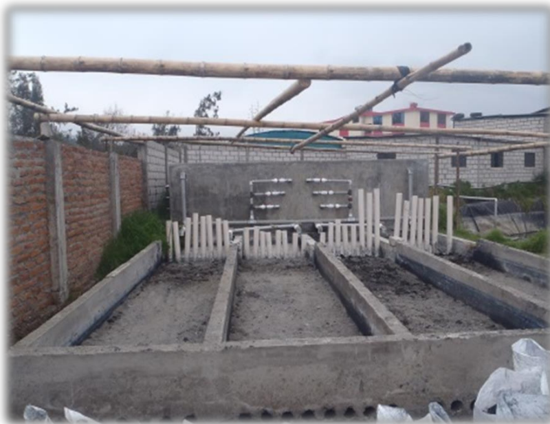
Fotografía 31.-Cisterna de abastecimiento de agua
