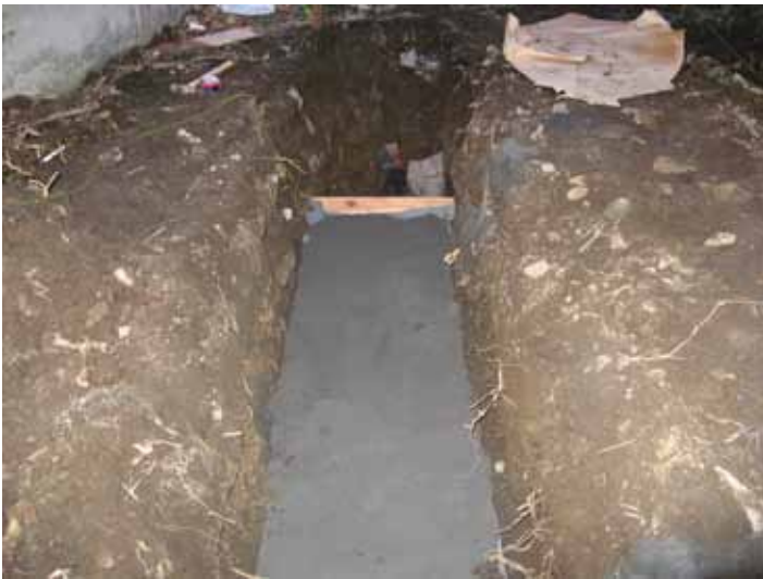
Fotografía No. 3 Relleno de zanja con arena
