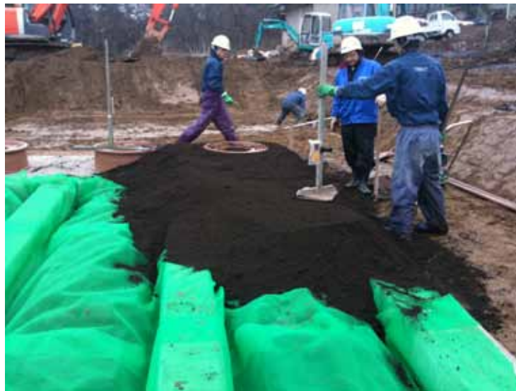
Fotografía No. 48 Nivelación de cubierta vegetal
