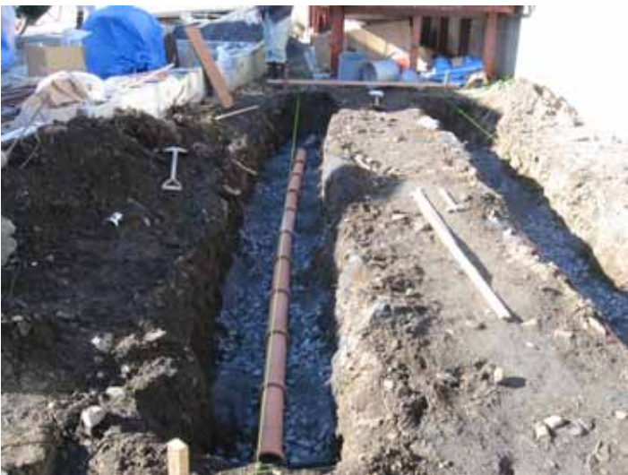
Fotografía No. 4 Instalación de primera capa de grava y colocación de tubería
