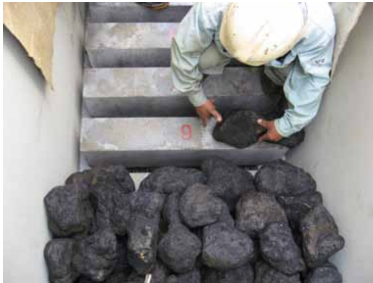
Fotografía No. 42 Colocación de grava
