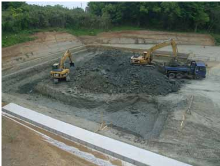
Fotografía No. 20 Perforación para tablaestacado y estabilización de bordos
