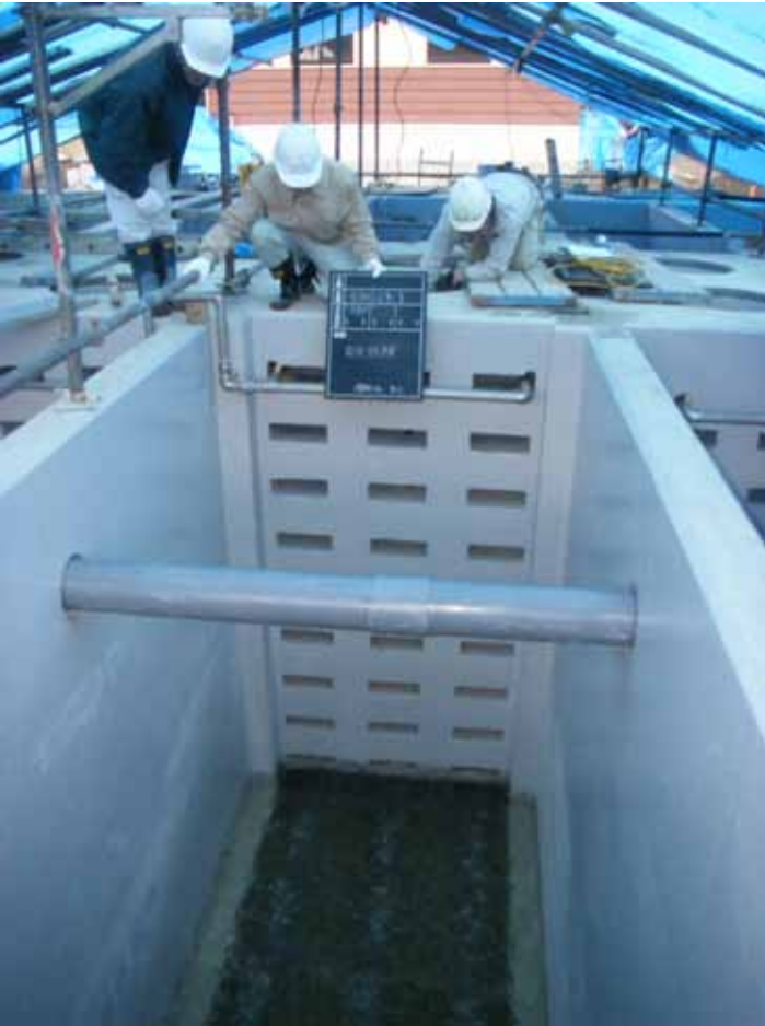
Fotografía No. 31 y No. 32 Pruebas del sistema de distribución de aire en reactor biológico
