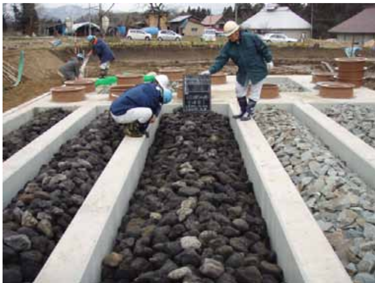
Fotografía No. 43 Cubierta final de grava
