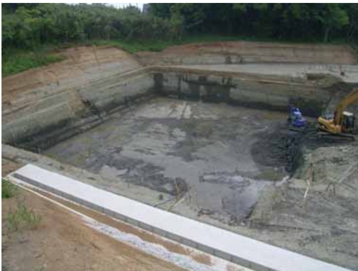
Fotografía No. 21 Tabla estacado
