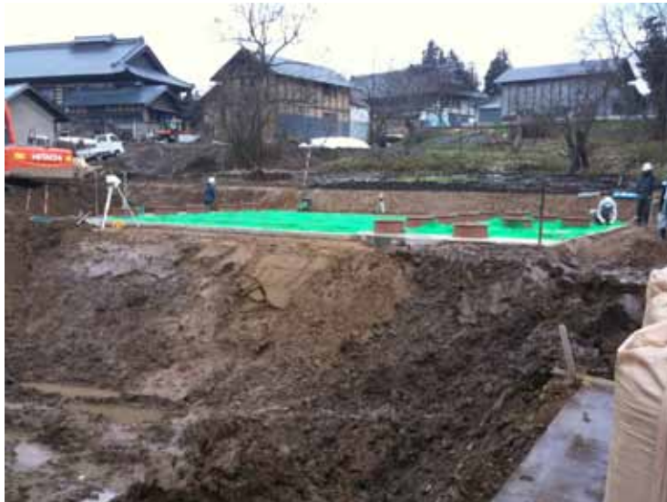
Fotografía No. 45 Verificación de correcta colocación de malla
