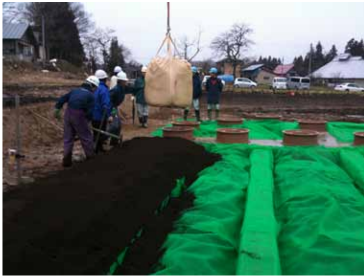
Fotografía No. 47 Relleno con cubierta vegetal
