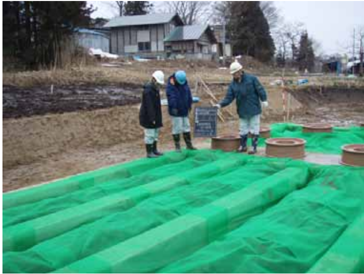
Fotografía No. 44 Colocación de malla
