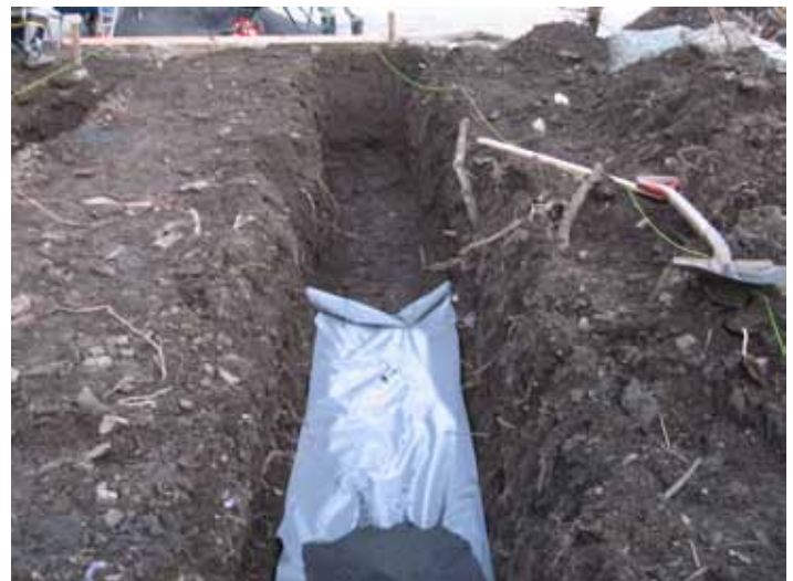
Fotografía No. 2 Instalación de película plástica
