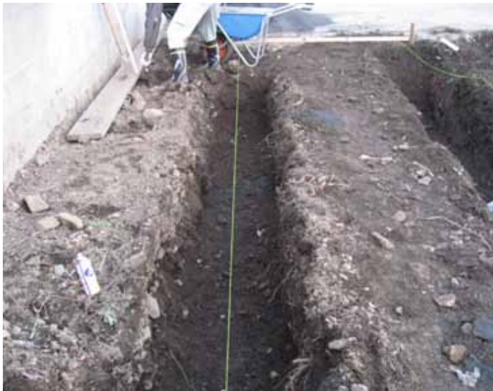
Fotografía No. 1 Características de la excavación de la zanja
