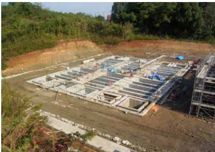
Fotografía No. 35 Colocación de traves de soporte
