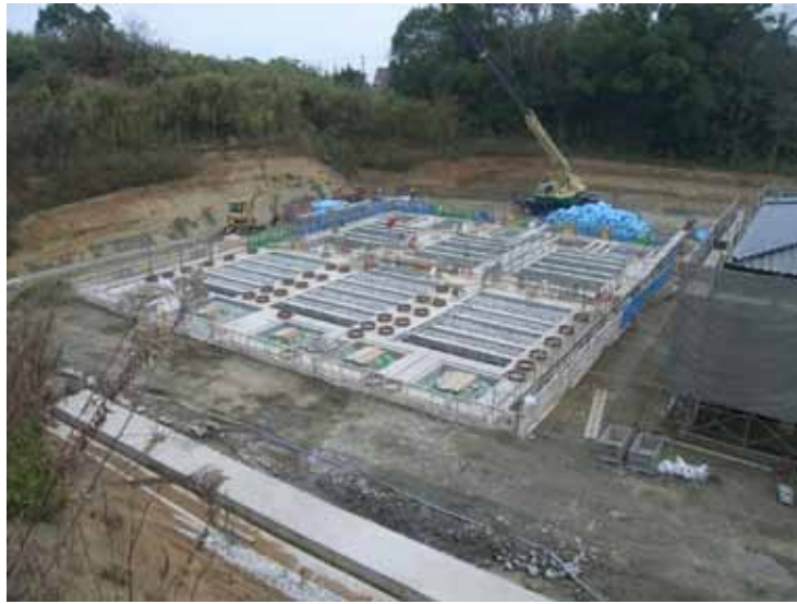
Fotografía No. 41 Instalación y llenado con grava de contacto
