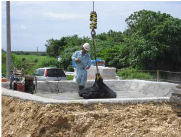
Fotografía No. 39 Transporte de grava de contacto
