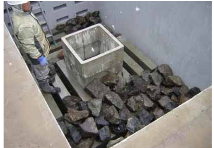
Fotografía No. 12 Colocación de grava lecho inferior
