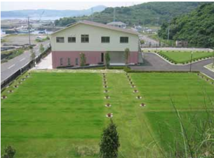
Fotografía No. 9 Vista de la planta de tratamiento terminada
