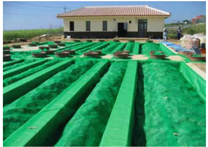
Fotografía No. 15 Instalación de la malla
