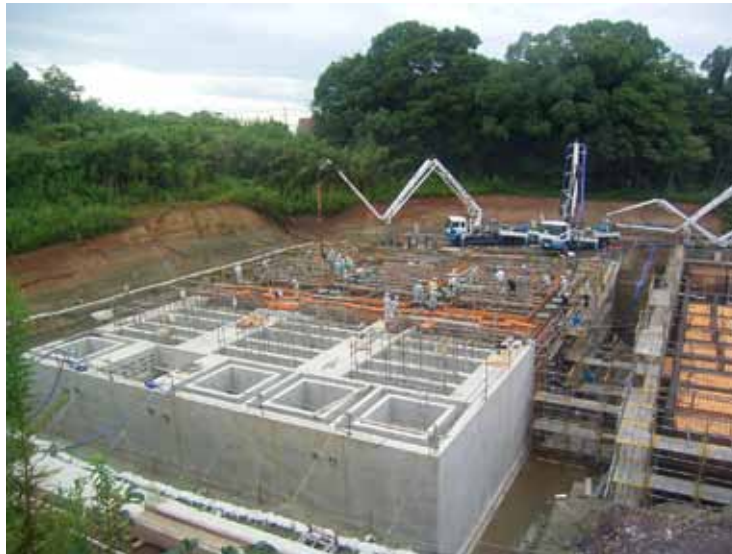
Fotografía No. 26 Armado de acero de refuerzo en losas
