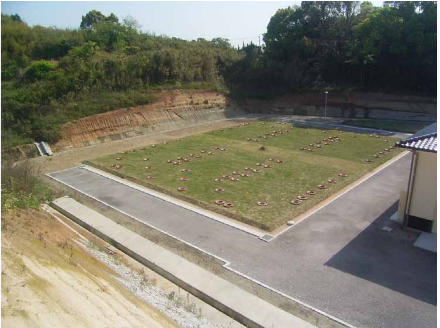
Fotografía No. 50 Obra terminada
