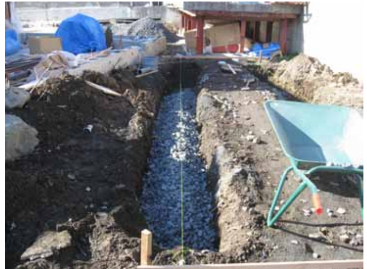
Fotografía No. 5 Instalación de la segunda capa de grava
