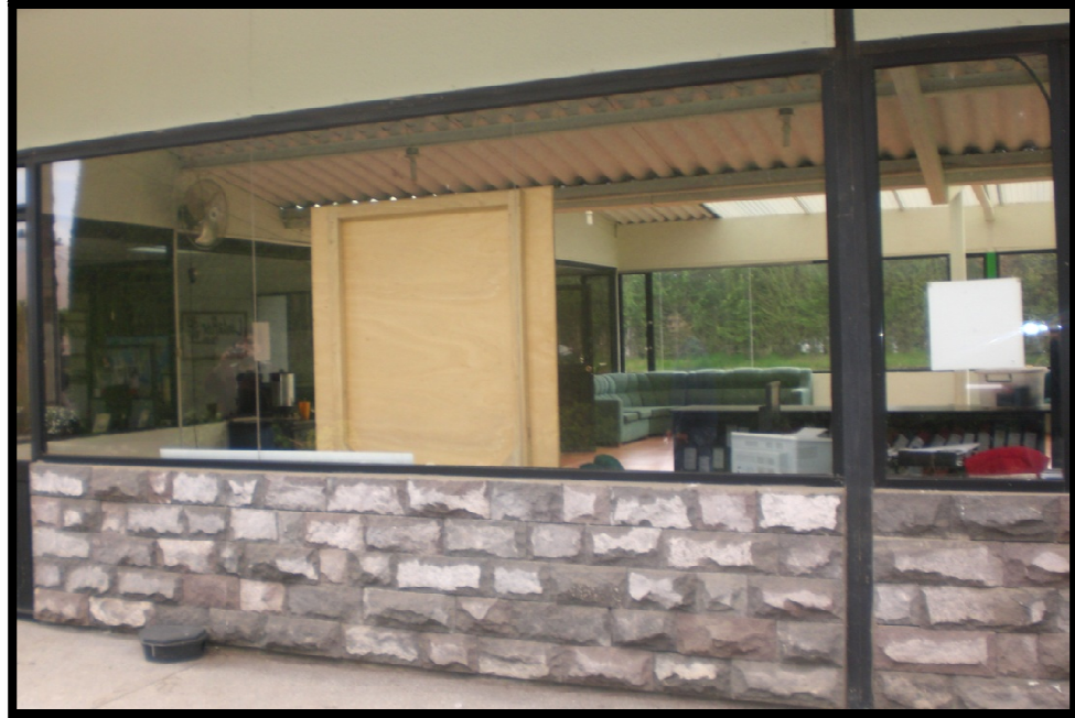
Oficinas del área administrativa
