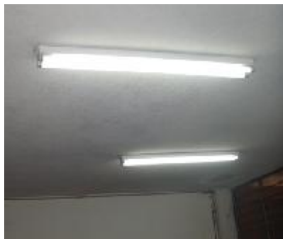
FIGURA 9. Iluminación Puesto de trabajo
