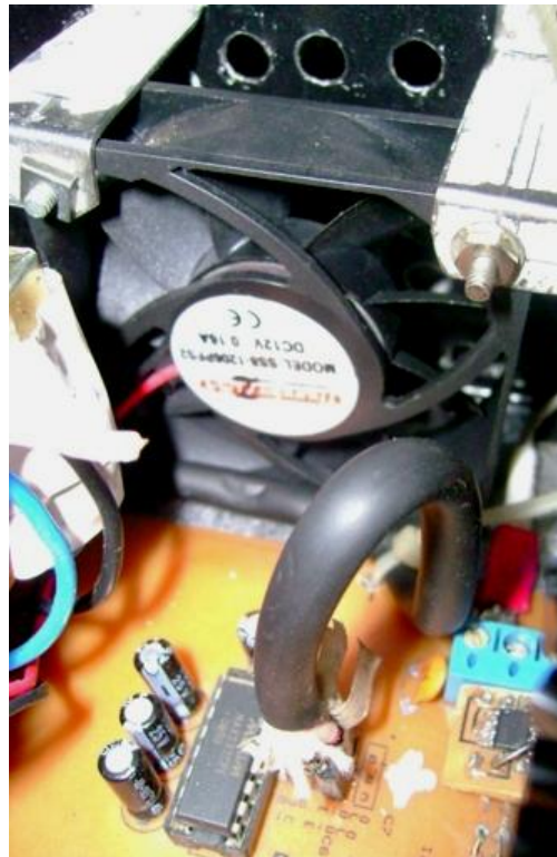
Gráfico Nº 69. Ventilador del Sistema Fuente: Sistema de Control Electrónico
