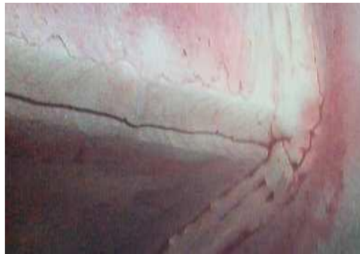
Gráfico N° 2. 22. Fisura Longitudinal
