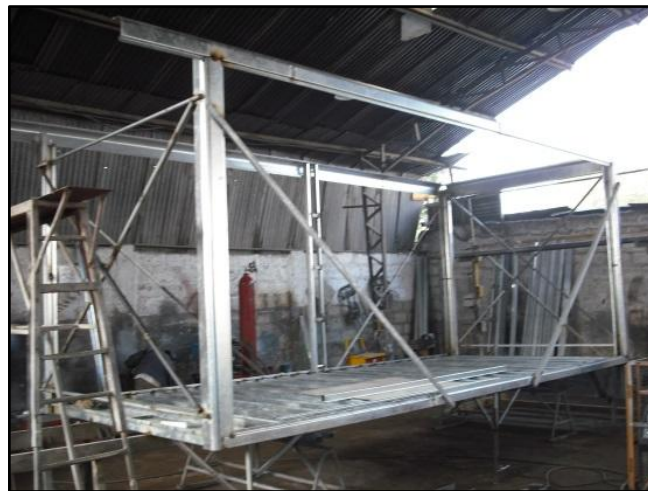
Fig. 19: Apuntalamiento de Cuadrante
