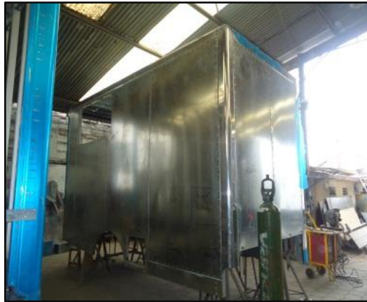
Fig. 23: Revestimiento exterior de furgón
