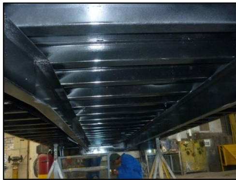
Fig. 25: Preparación de furgón previo al montaje
