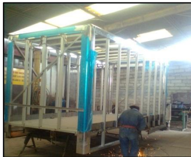
Fig. 21: Remate de soldadura
