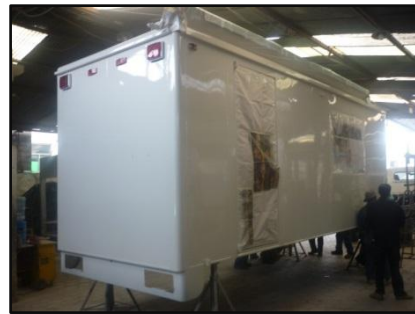
Fig. 30: Aplicación de pintura en unidad
