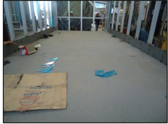
Fig. 15: Instalación de forro para conformación de piso
