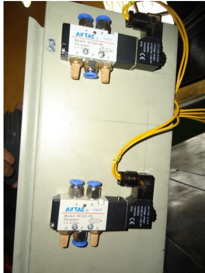
IMAGEN 6.8.- Sujeción de las electroválvulas en la caja. 53
