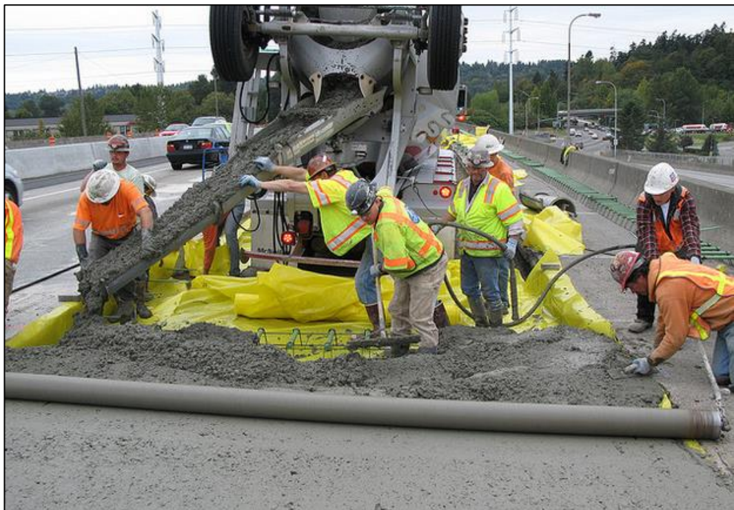
Figura 11: Trabajabilidad del hormigón
