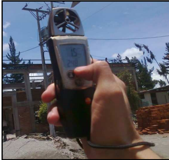
Figura 3.9 Medición de la Temperatura Ambiente, Velocidad de Viento y Humedad Relativa con el Anemómetro.
