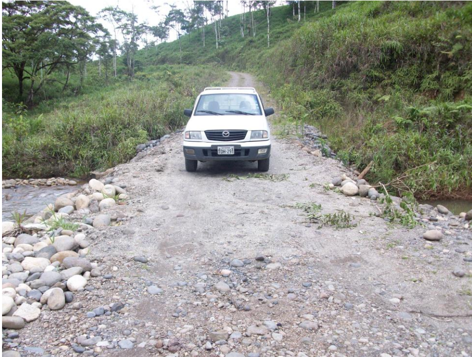
Alcantarilla circular en la abscisa 4+940 de hormigón armado, el ancho de vía disminuye a 3.80 m.
