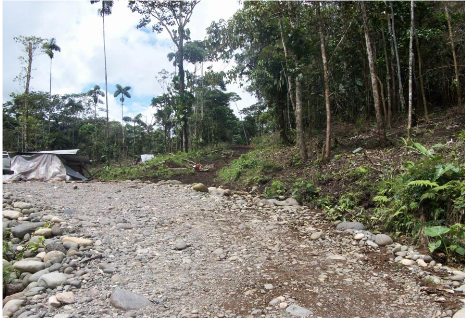
Punto de inicio del tramo de vía lastrado.
