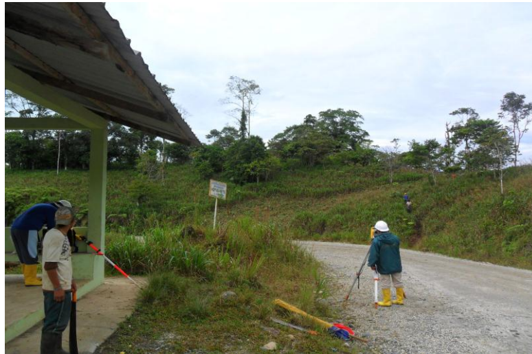
Levantamiento de la faja topográfica con estación total en la cota inicial del proyecto
