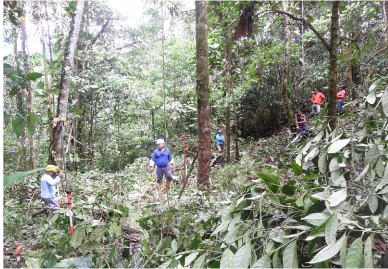
Desbroce del monte para abrir la trocha por donde se va avanzando con el levantamiento de la faja topográfica.
