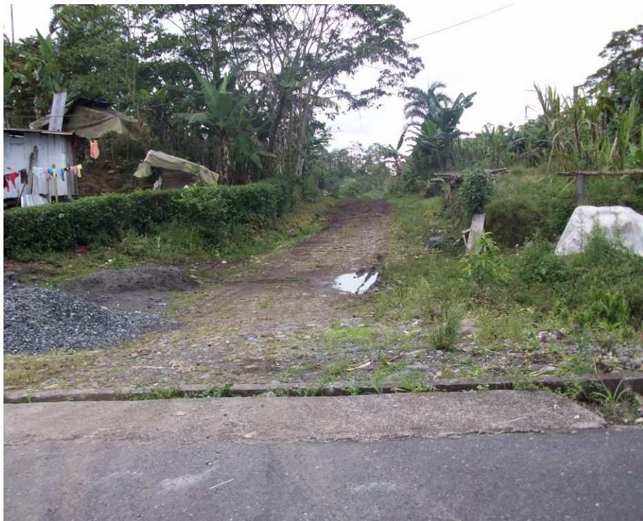
Punto final de la vía en la abscisa 5+210, en la vía Puyo – Tena Km. 24
