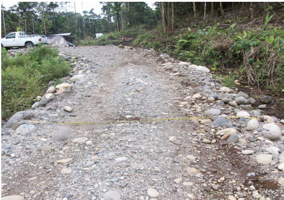
El ancho de la vía existente en el tramo inicial es de 4.00 m.
