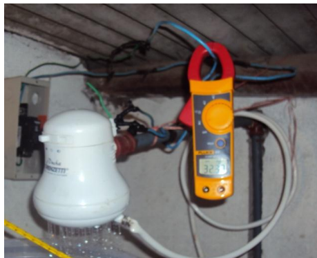
Figura 4. 12 Medición del amperaje
