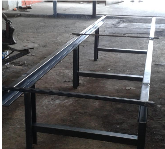
Anexo B1: Construcción de la estructura para cinta transportadora
