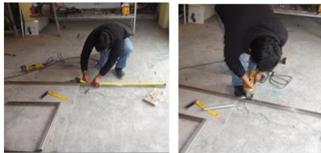
Figura 6.29: Trazado y corte de vigas y columnas de la estructura
