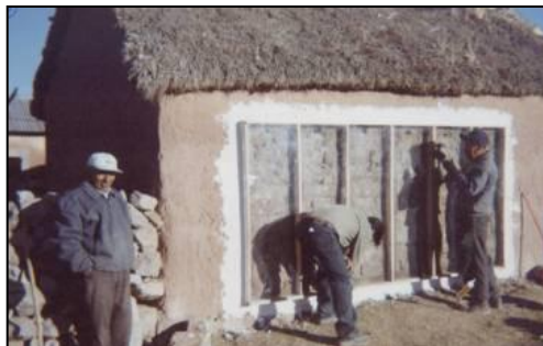
Figura 1.2: Construcción de muro Trombe en Chilacollo, Perú.
